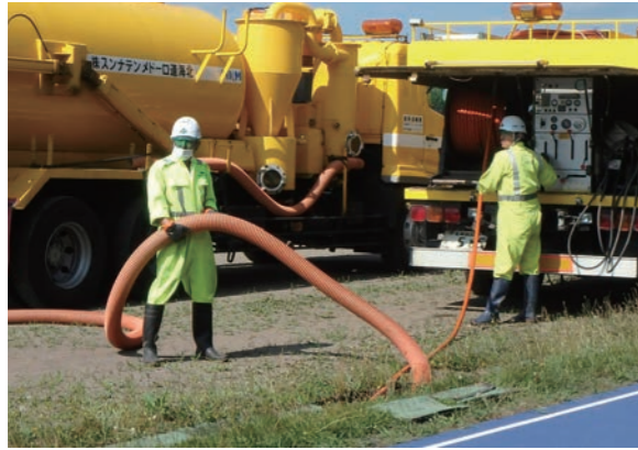
北海道ロードメンテナンス(株)による地域貢献事業が8月6日(金)に行われ、総合グラウンド(体育館側)の側溝土砂除去作業を実施していただきました。
