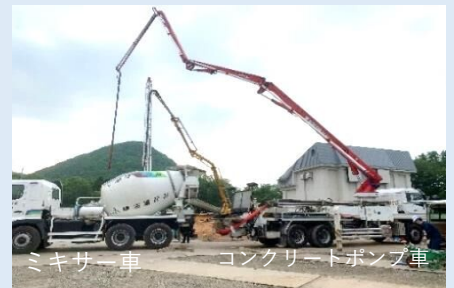
コンクリート打設に使う車たち
