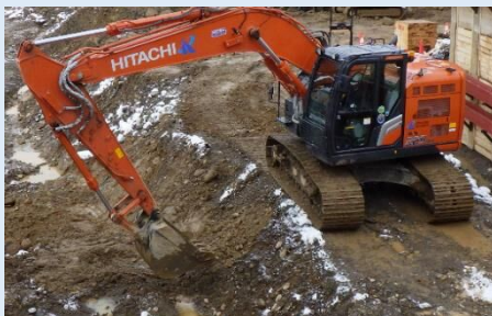
バックホウ (土を掘る機械)
