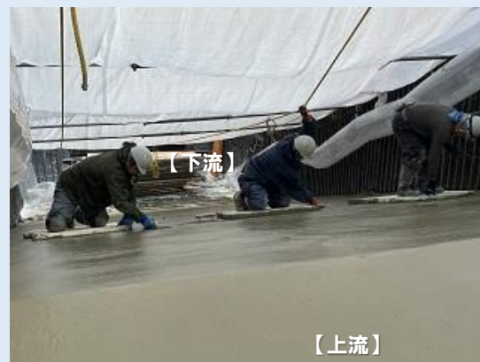
写真⑤ 放水池底版コンクリート均し状況 (2024年10月)
