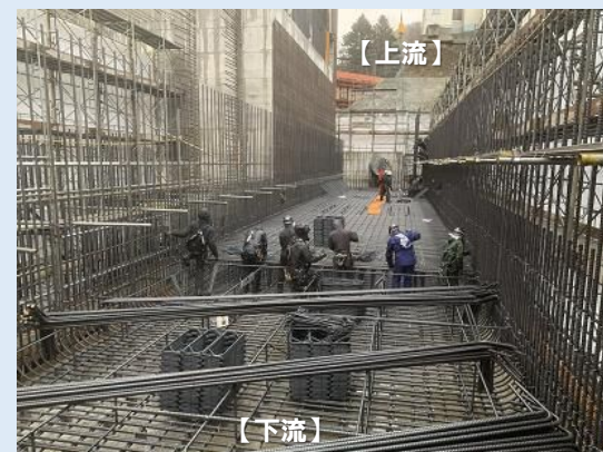
写真⑥ 余水放流設備の鉄筋組立状況 (2024年11月)
