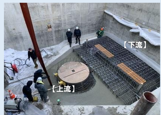
写真② 吸出し管のコンクリート埋設作業状況 (2024年12月)
