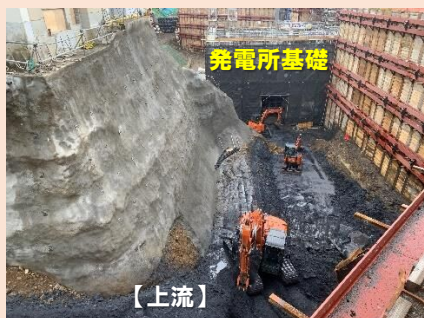
掘削状況（上流側5段目） 【掘削深さ 約14m】
