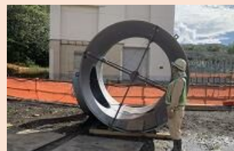
水圧鉄管の大きさ 【直径2.5m】
