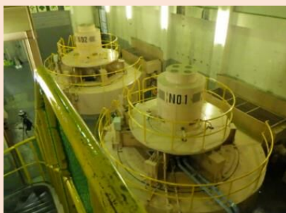
上川発電所の内部：停止した発電機 【水車に直結されている】
