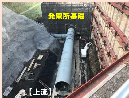
水圧鉄管の据付状況 【下：上流から】【上：水車(下流)へ】
