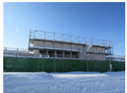
(建設中の認定こども園)
