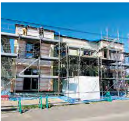
建設中の旭町望岳団地
