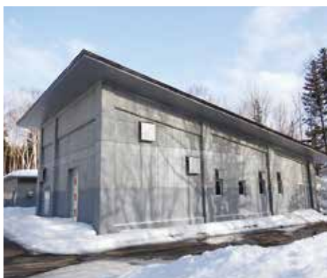
旭ヶ丘水道施設
