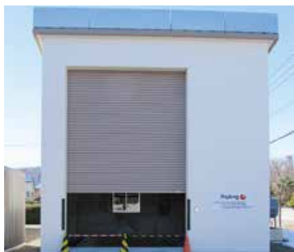
上川医療センター バイオマスボイラー棟
