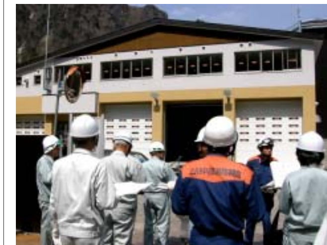
建設中の層雲峡新消防庁舎
