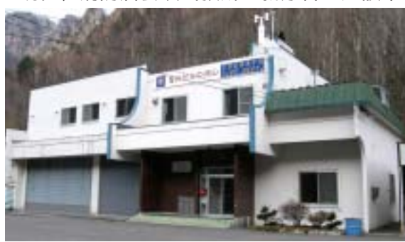
現在、消防層雲峡出張所の新庁舎を建設中
