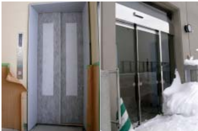
エレベーター
