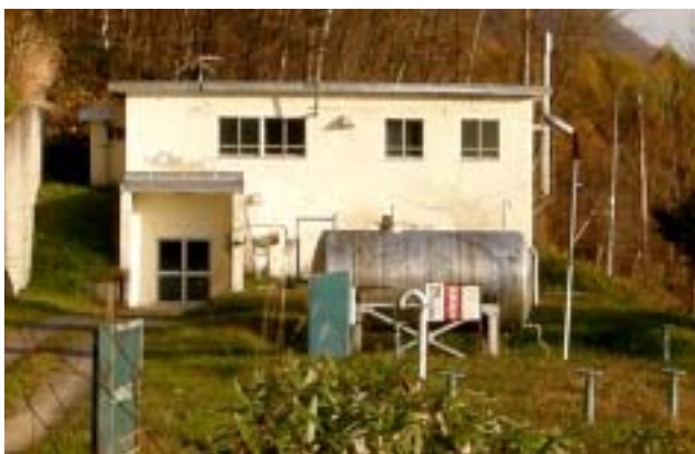
上川中央浄水場
