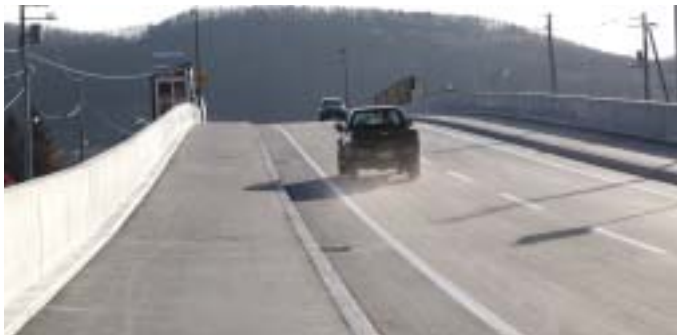
供用開始したかみかわ跨線橋
