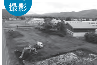
敷地造成工事開始
