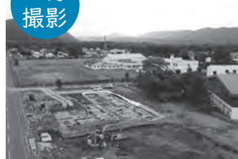
園舎建設工事開始
