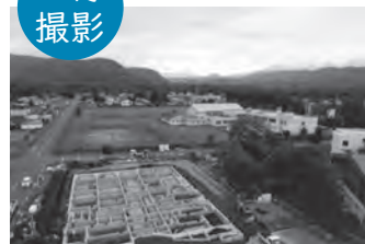
基礎コンクリート打設
