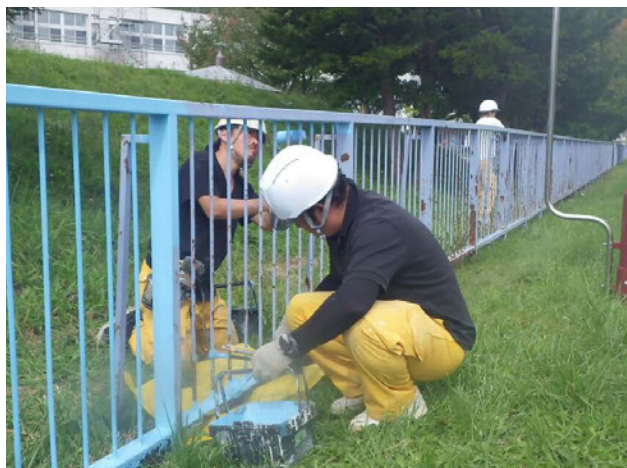
小学校のフェンスの塗装
